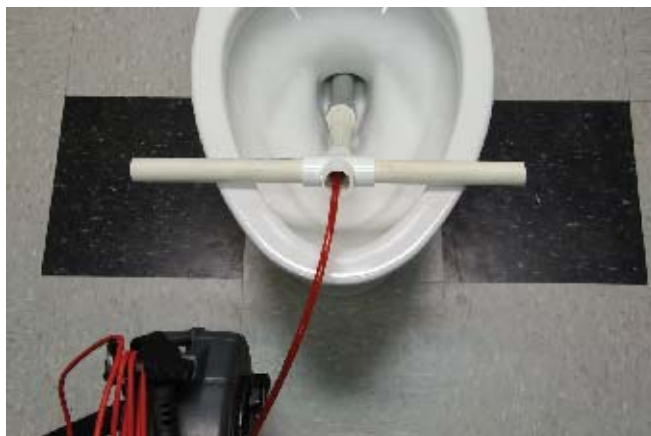
Рисунок 22 – Использование ПВХ направляющей трубки
