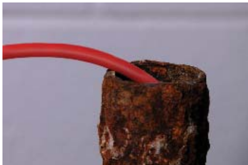
Рисунок 15 – Избегайте вытягивания по острым углом
