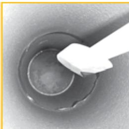
18. Удалите избыточное количество герметика Rotempero с внутренней поверхности трубы при помощи влажной губки или специальной лопатки.
