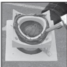
26. На внутреннюю часть элемента для подключения потребителя обильно нанесите герметик Rotempero.
