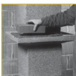
47. При обмурывке кирпичом верхней части дымохода, используется консольная плита. На ней устанавливаются каменные оболочки, а позднее вокруг выполняется кирпичная кладка.
