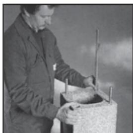
34. Вставьте арматурные стержни в специальные каналы. Упоры на арматурных стержнях с резьбой не позволяют им провалиться внутрь. Количество стержней определяется проектом.
