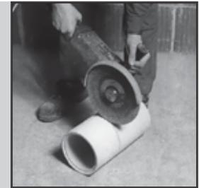
44. Обрежьте керамическую трубу угловой шлифовальной машиной, после чего очистите оба конца трубы от пыли. Обильно нанесите на трубу герметик Rotempo и установите её на место.
