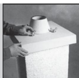
46. Закрепите покровную плиту при помощи винтов.
