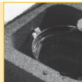
8. Нанесите на верхнюю кромку ёмкости для сбора и отвода конденсата достаточное количество герметика Rotempero. Температура монтажа должна быть  $\geq 5^{\circ}\text{C}$ .
