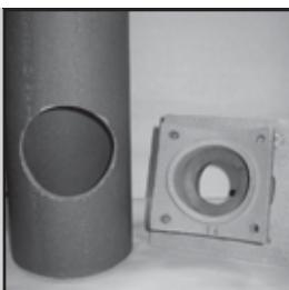
22. Выполните в керамической трубе отверстие Ø 112 мм при помощи буровой коронки. Допускается выполнять отверстие в трубе не только круглой, но и квадратной формы (рис. 23).
