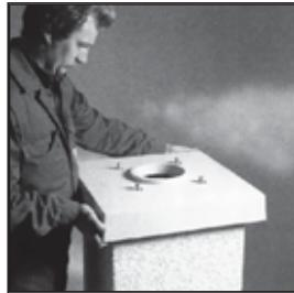
41. Положение покровной плиты проверьте уровнем.
