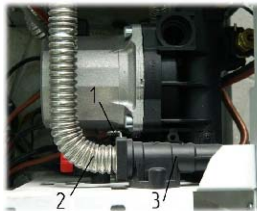
Рис. 18. Демонтаж клапана байпаса
