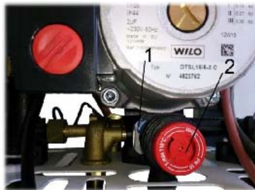
Рис. 21 Демонтаж предохранительного клапана
