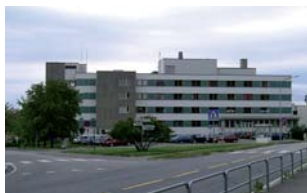
ГОРОДСКОЙ ГОСПИТАЛЬ HAUGESUND, ХАУГЕСУНД - НОРВЕГИЯ
