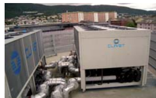
ОФИСНЫЙ ЦЕНТР SKIPSYBGGERHALLEN, СОЛХЕЙМСВИКЕН - НОРВЕГИЯ
