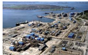
НЕОТЕПЕРОГОННЫЙ ЗАВОД STATOIL, КАРСТО - НОРВЕГИЯ
