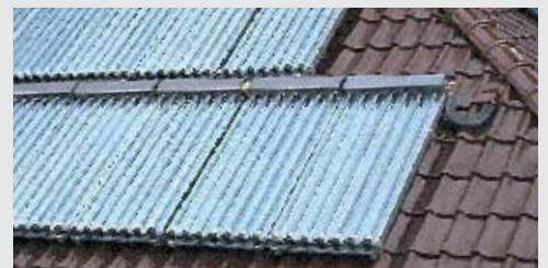
Установка на крыше
