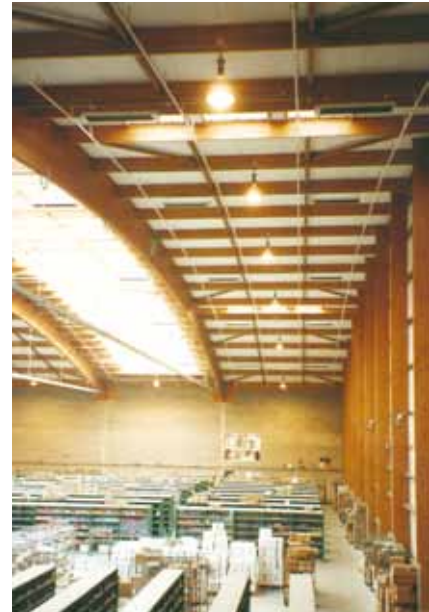
Особенно выгодно использовать инфракрасные обогреватели в помещениях с большой высотой потолков. Экономия по сравнению с традиционными видами отопления может составлять 30-40%.
