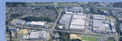
Air Conditioning Division (Appliances Company) (г. Шига, Япония)
