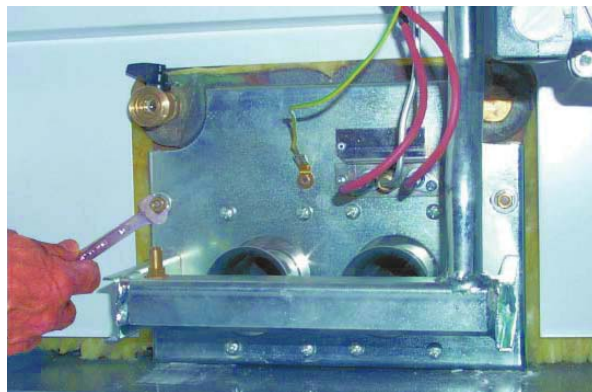
рис. 20 - Демонтаж горелок
