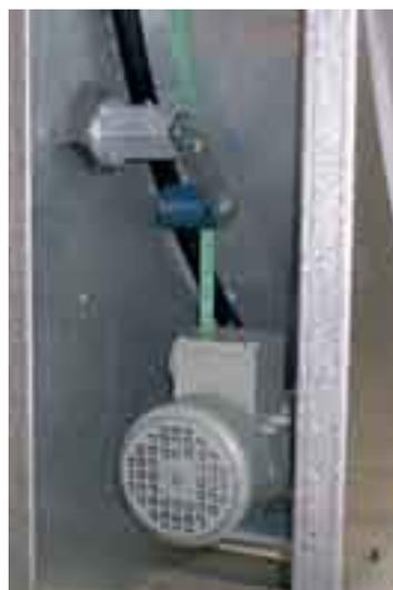
*Электродвигатель роторного рекуператора*
