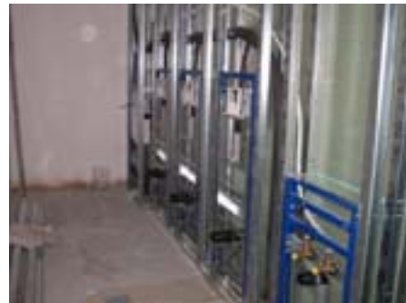
Монтаж умывальников в ряд «сухим» способом
