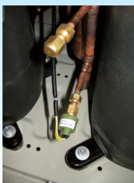
Предохранительные клапаны высокого давления
