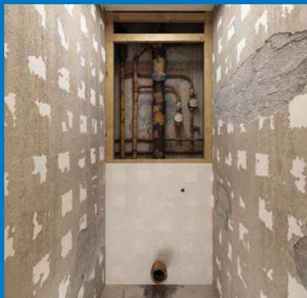
Плитка, старый унитаз и задняя стенка удалены.
