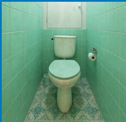
Типовой санузел до реконструкции.
