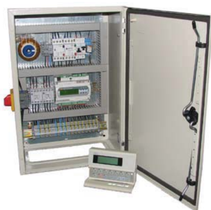
Рисунок 4.2. Исполнение щита управления в металлическом корпусе
