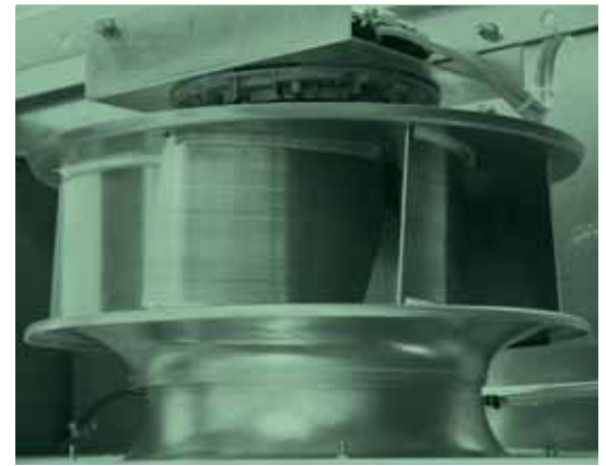
ЕС-вентилятор с плавным электронным регулированием частоты вращения
