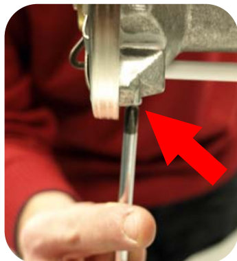
5- Вывинтить крепежный винт электрода розжига.
