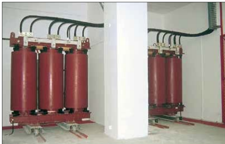
Стандартные присоединения ВН и НН сверху
