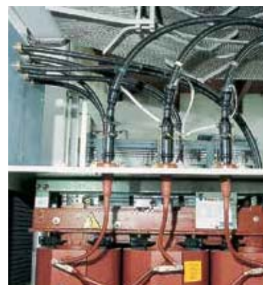
Присоединения ВН сверху через разъемы (1) (на заказ)
