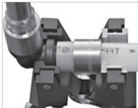
Монтаж отводов и тройников из PPSU с никелированными трубками
