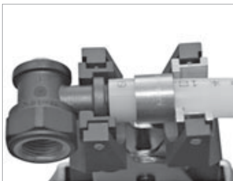
Монтаж отводов фиксируемых из PPSU
