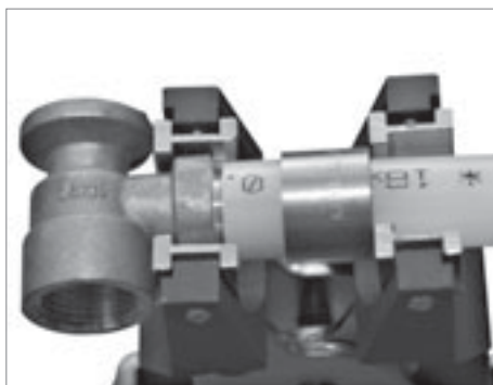
Монтаж отводов фиксируемых латунных
