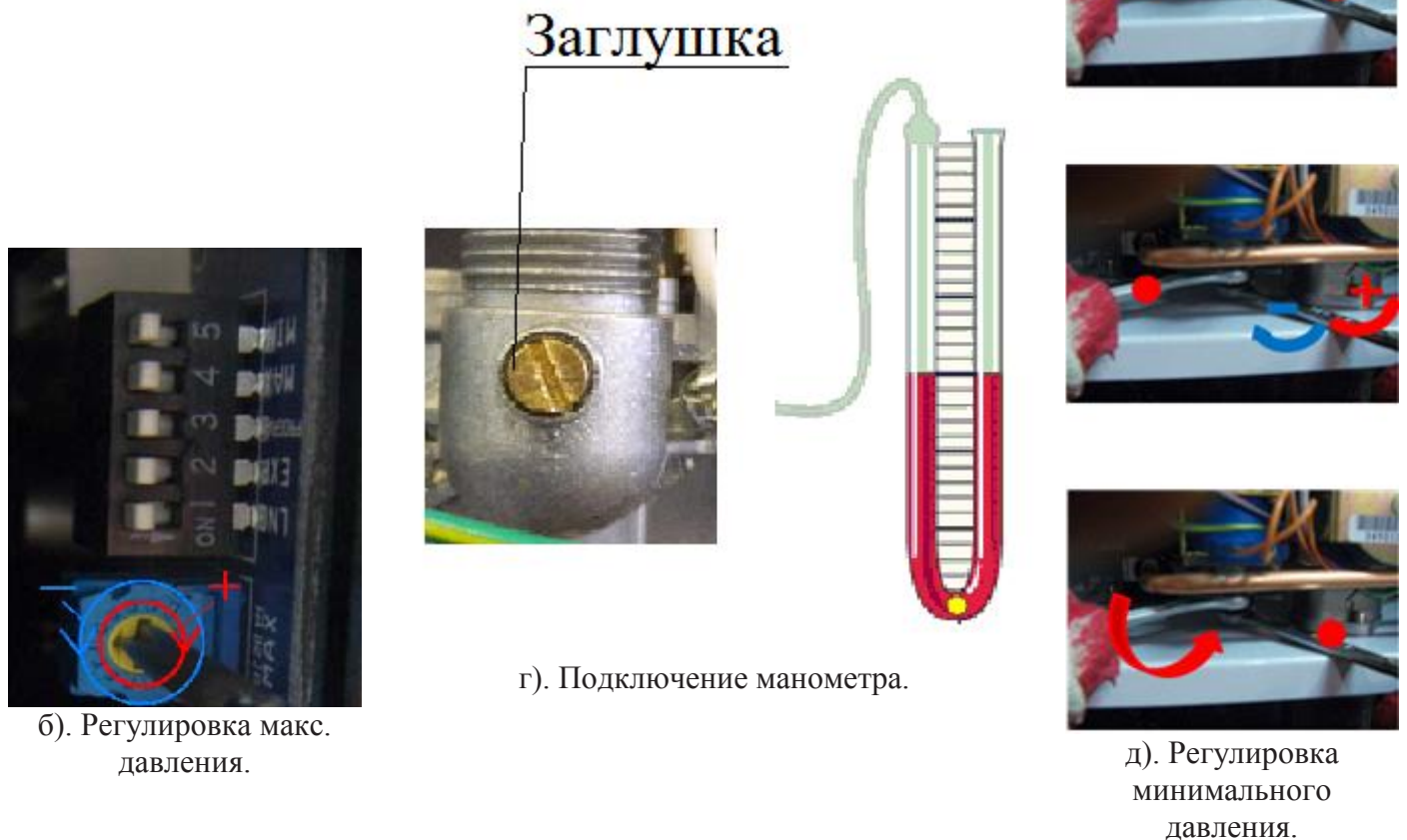
Рис. 9. Регулировка давления газа
