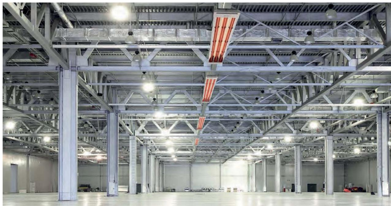
Цельный отражатель из жаропрочной нержавеющей стали обеспечивает неизменно высокую эффективность обогрева
