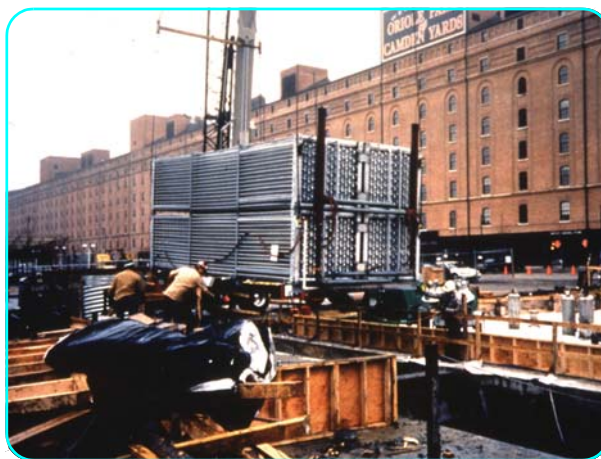
Установка змеевиков в бетонный резервуар
