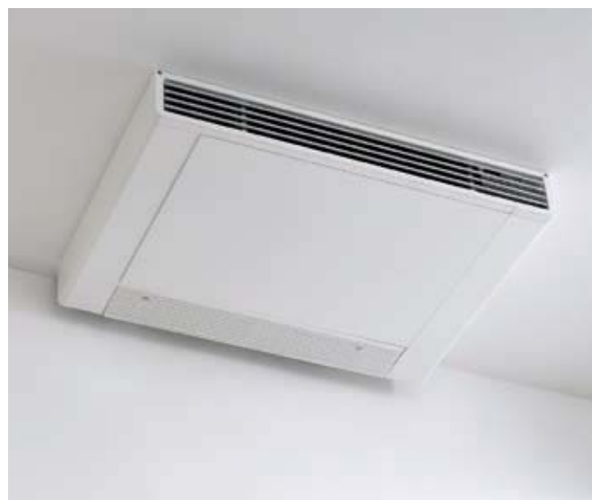
Фанкойл закреплен на потолке
