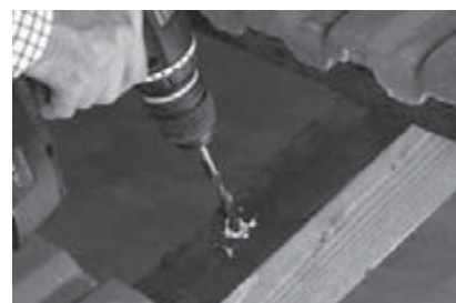
Шаг 2. Сверление отверстия в стропиле
