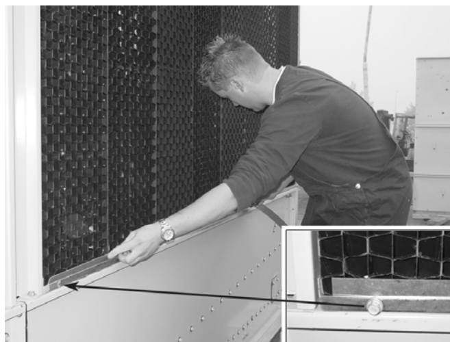
Рисунок 14: Снятие транспортных скоб
