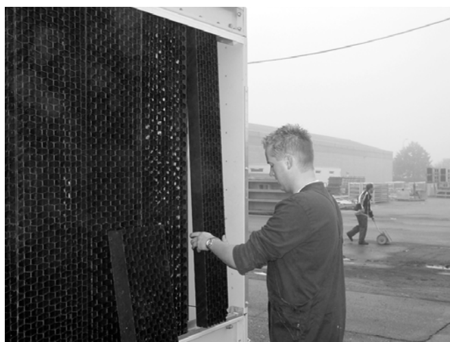
Рисунок 15: Снятие комбинированных экранов на входе
