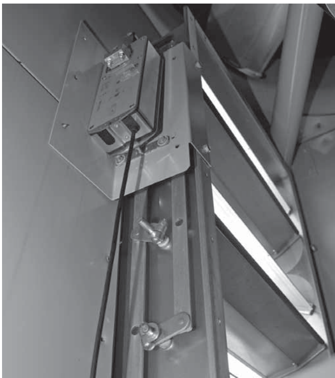
Рисунок 12: Привод регулирующих демпферов на впуске воздуха
