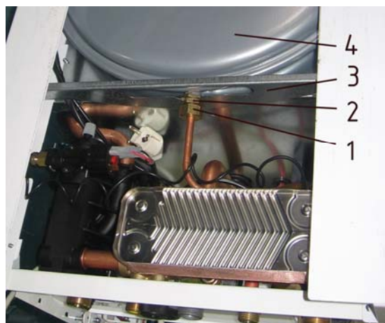
Рис. 25. Демонтаж трубы расширительного бака
