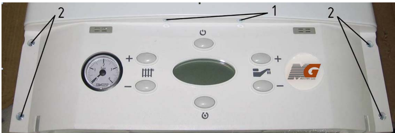
Рис. 16. Демонтаж облицовки и передней панели
