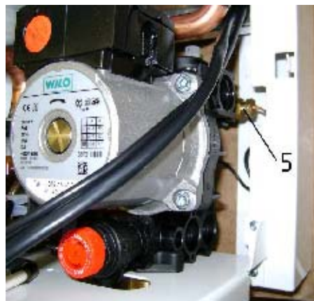
Рис. 21. Демонтаж насоса
