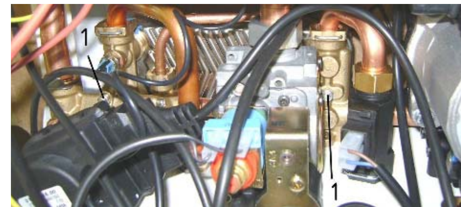
Рис. 22. Демонтаж вторичного теплообменника
