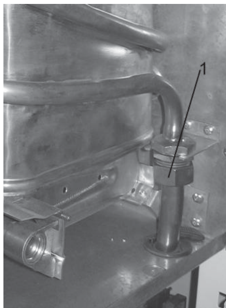
Рис. 20. Демонтаж трубы насоса
