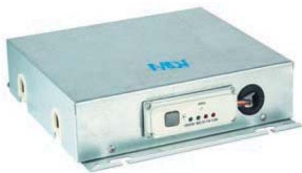
Комплект автоматики для фанкойлов серий MDKT, MDKH и MDKF. Позволяют реализовать управление с центрального контроллера CCM03, и использовать все возможности диспетчеризации, используя шлюзы протоколов BACNet и LonWorks.
