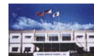
Hitachi Air Conditioning, Филиппины
