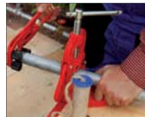
Обработка края резьбы
