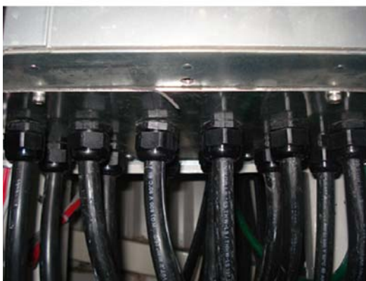
Рисунок 3.32: Пример правильной установки платы уплотнений.
