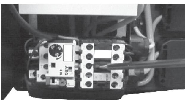
После завершения работ по подключению необходимо проверить правильность подключения электропроводки и задействовав кратковременно защиту электродвигателя горелки с помощью изолированной отвёртки, проверить направление его вращения. Направление вращения считается правильным, если колесо вентилятора вращается в направлении стрелки на фланце электродвигателя)
