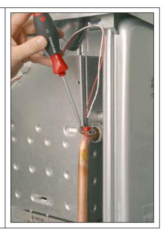
2. С помощью плоскогубцев снять фиксатор трубки возврата;
