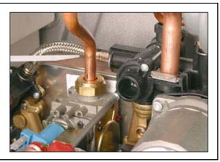
**3.** Сняв суппорт привода, можно вынуть затвор трехходового клапана;
