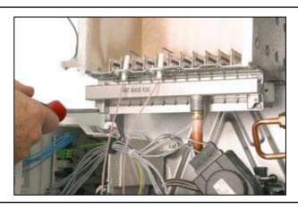
**5.** Отсоединить газовый коллектор от горелки;
