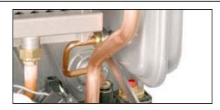
2. Выкрутить винт крепления расширительного бака к шасси котла;
