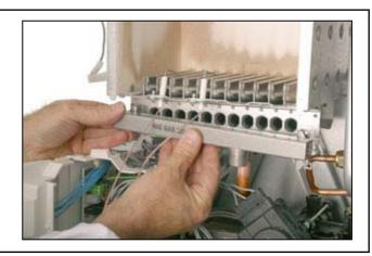
**6.** Выкрутить два винта, крепящие горелку к камере сгорания;
