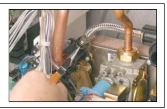
2. Снять трубку байпаса и выкрутить 2 винта «А» и «В», которые крепят вторичный теплообменник к узлам подачи и возврата;
