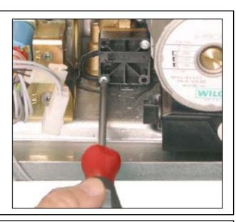
**2.** Снять датчик протока ГВС и отсоединить разъем провода датчика.
