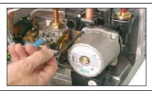
**3.** Вынуть двигатель и крыльчатку насоса.
