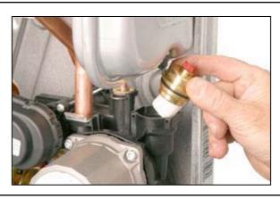
1.3.5 Демонтаж двигателя и крыльчатки насоса.
