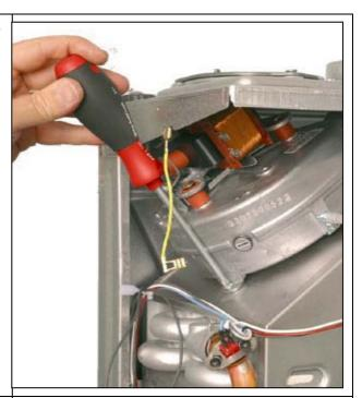
2. Теперь есть возможность снять вентилятор.
