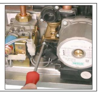
**2.** Отсоединить разъемы проводов питания и электрода розжига.
