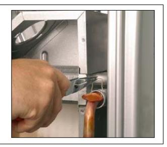
**3.** Отсоединить фиксатор трубки возврата от насоса;
