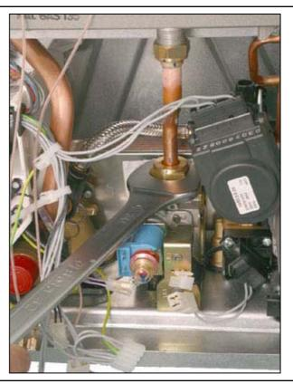
3. Выкрутить 2 винта, которые крепят газовый клапан к шасси котла;
