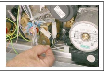
**4.** Открутить 4 винта, фиксирующие газовый коллектор к горелке;
