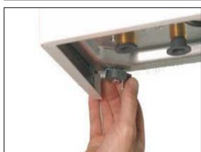
4. Приподнять и снять с котла наружный кожух.
