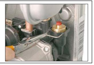
**2.** Вынуть клапан из посадочного гнезда.
