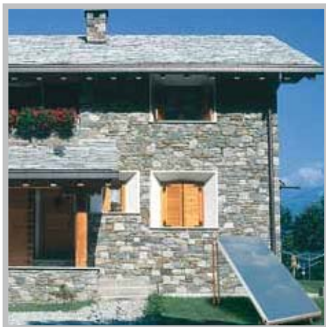
Пример наземного монтажа
